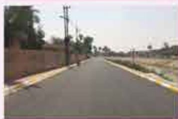
伊拉克穆沙拉道路改造前後
