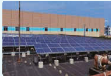
光伏發電系統
