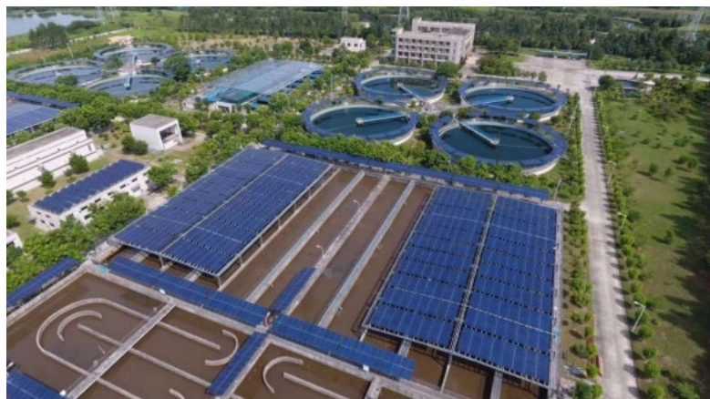
分佈式光伏發電
