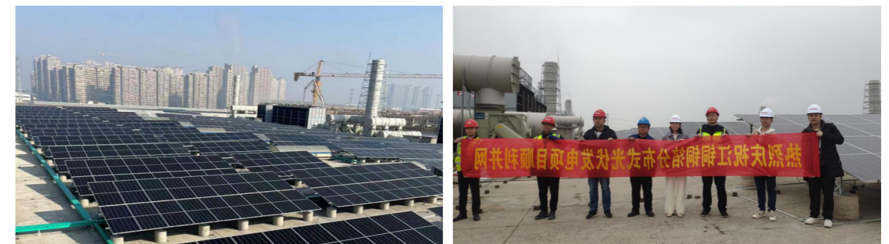
圖：光伏發電專案現場圖
