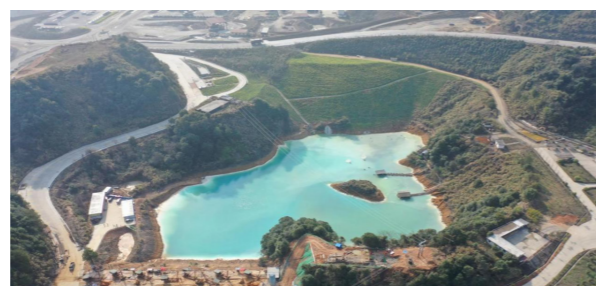
圖：楊桃塢酸性水庫防滲治理工程現場施工照片
