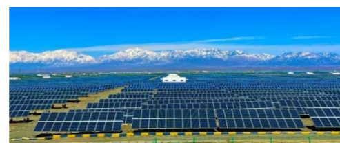
石城子光伏電站
