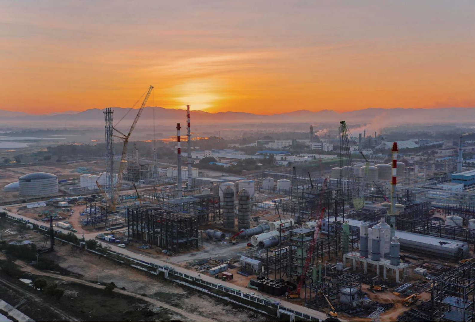
海南丙烯腈項目建設
