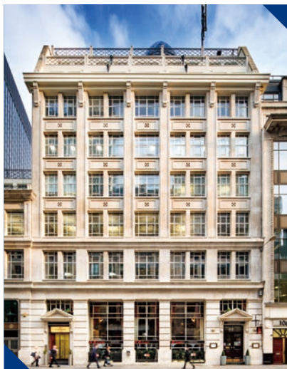
• 倫敦 Leadenhall Street 107號
