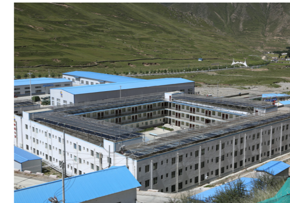
西藏華泰龍鋪設太陽能建設無煙礦區
