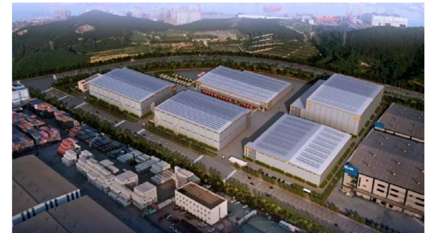
万纬青岛前湾港冷链园区
