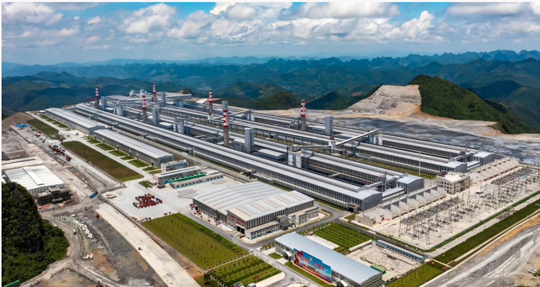
中鋁國際和貴陽院設計、六冶施工總承包的雲南神火鋁業有限公司 90 萬噸綠色水電鋁材一體化項目
