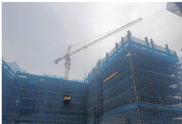
(第四期校舍建設)
