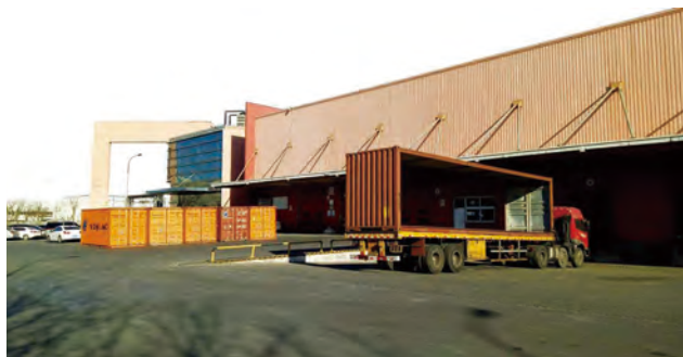
天津港保稅區國際物流中心
