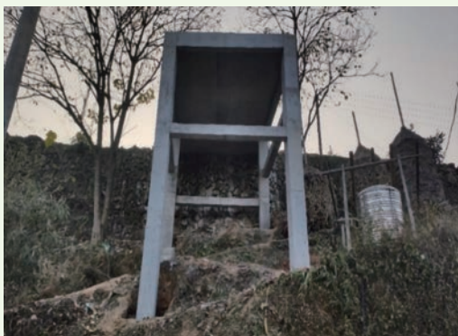
圖為：融水縣大新村便民涼亭建設主體已完成
