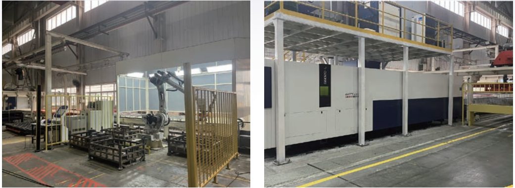
圖為：東風柳汽激光切割降噪改造項目
