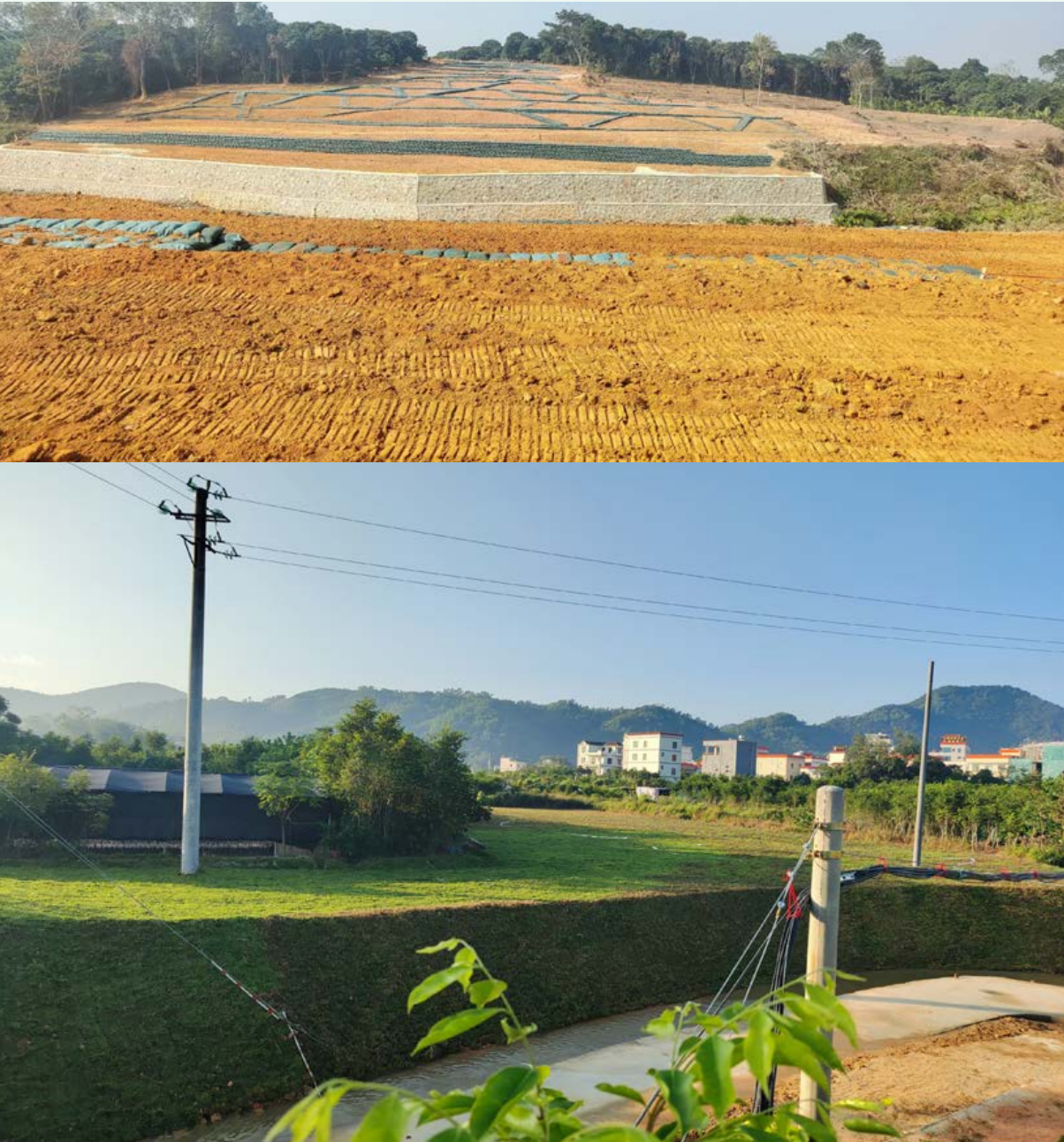
▲ 广州工程博茂油品管道建设项目实施生态自然保护
