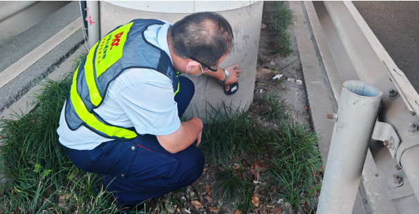
▲ 浙江省分公司及時檢修水浸設備感測器，確保災情數據和信息發送及時準確
