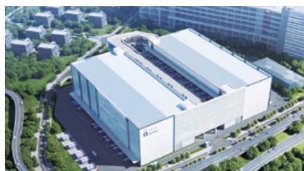
2 深國際西部公路樞紐物流園(深圳寶安)#
