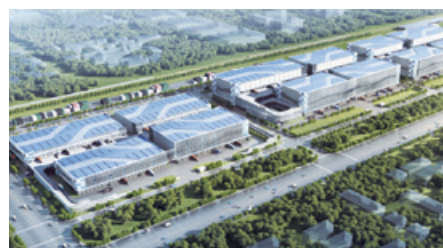
21 深國際京西南綜合物流樞紐 (一期)智慧物流中心#
