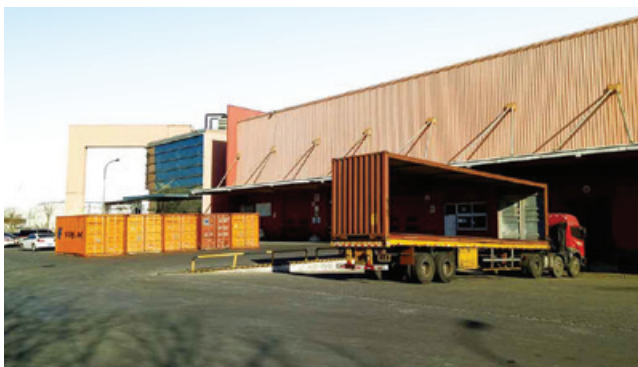
天津港保稅區國際物流中心
