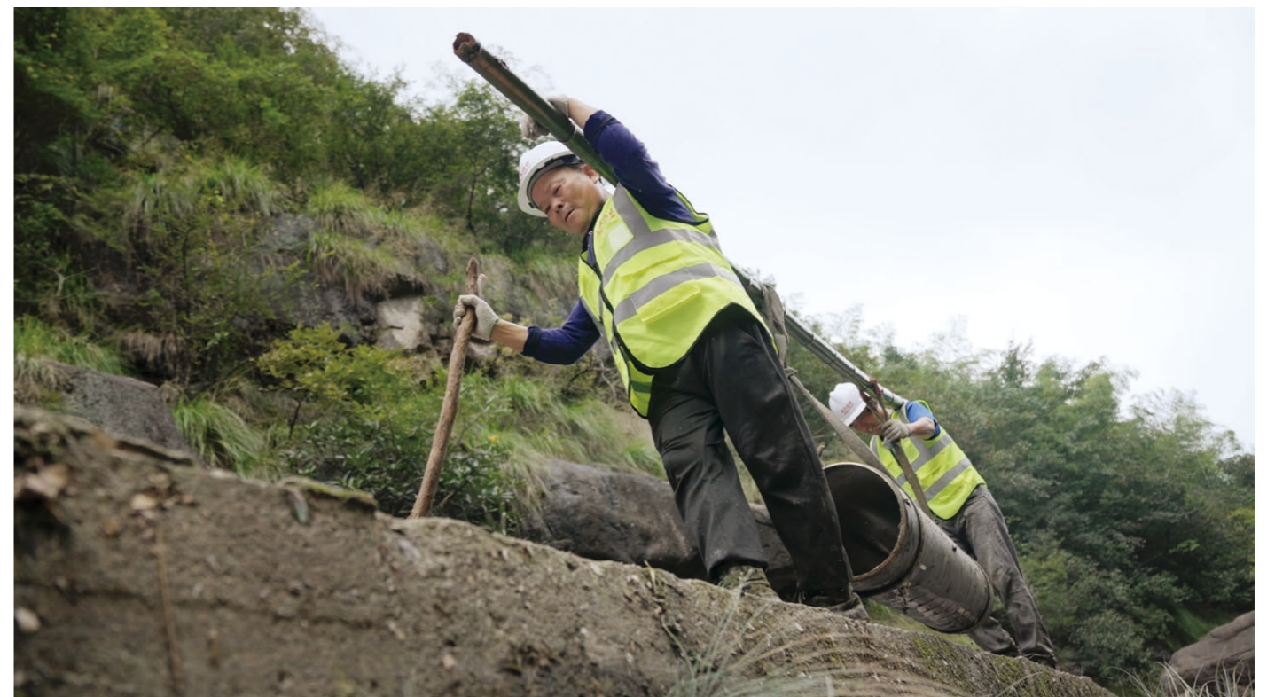
在安徽黃山工廠建設過程中，工人採用手提肩扛等方式搬運輸水管道
