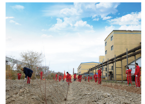
廠區綠化工程現場
