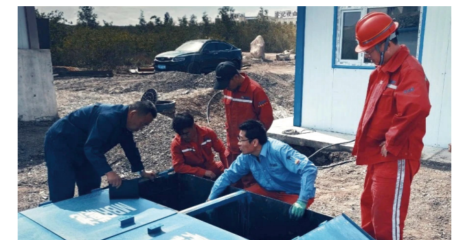
亞克斯公司污水處理站
