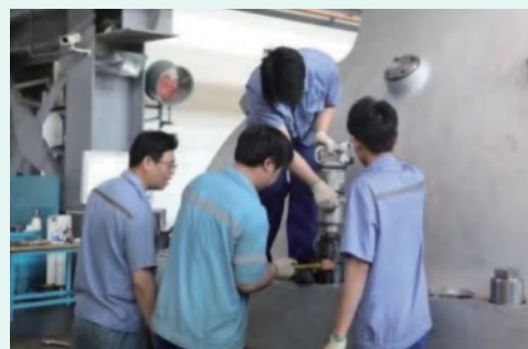
完成華事德大修項目一期四台機組大修
