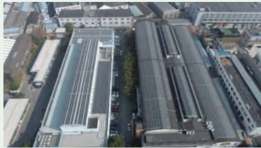
屋頂安裝分布式光伏發電系統
