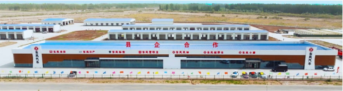
柯坪縣東風機電科技園
