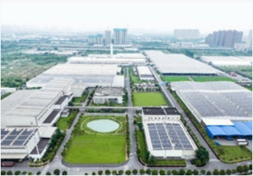
嵐圖綠色工廠光伏發電項目
