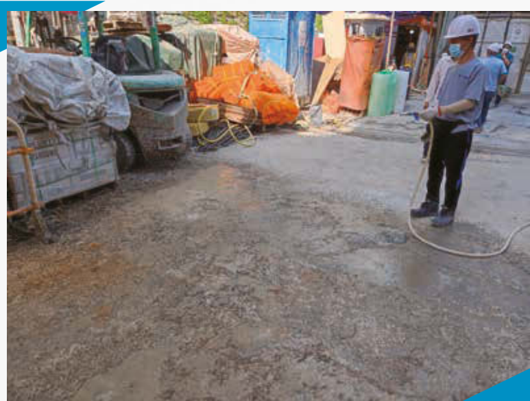
Watering dusty exposed areas 對暴露於塵垢的地方澆水
