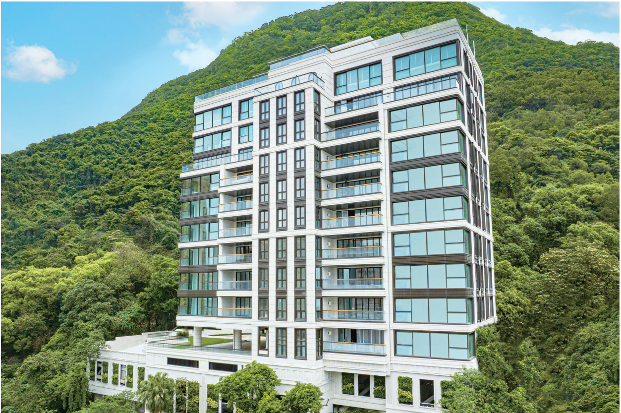
位於寶珊道的「寶峰」住宅發展項目
