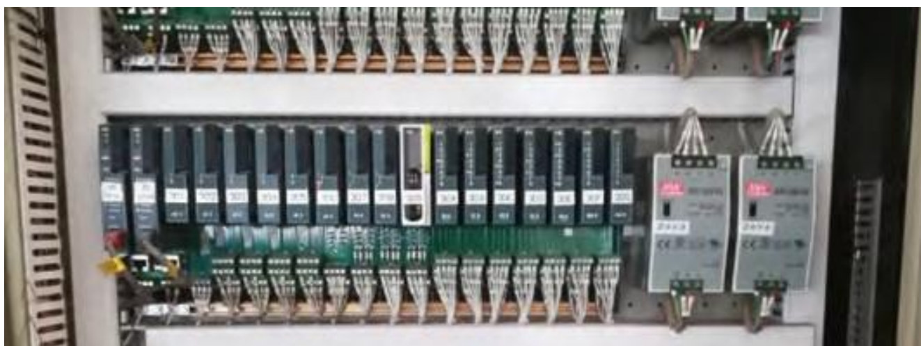
天瑞集團鄭州水泥有限公司回轉窯餘熱發電控制站
