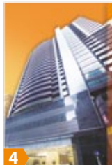
4 Prosperity Place 泓富廣場
