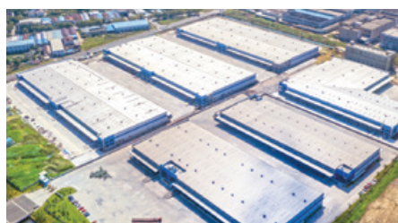
7 Wuxi Huishan Project
