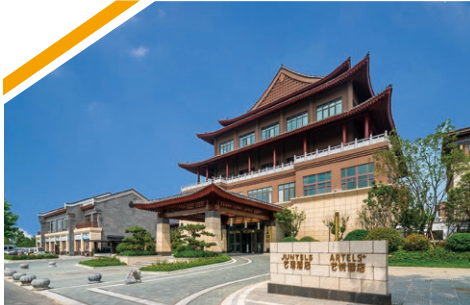
ARTELS+ AND JUNTELS PENGLAI YANTAI
