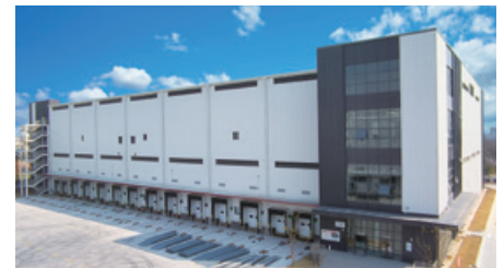
12 SZI Cold Chain (Nanjing Jiangning)
