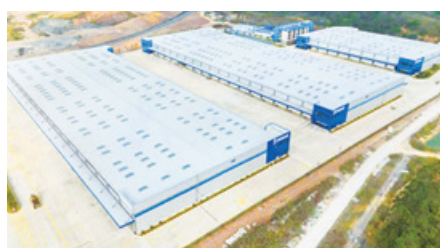
38 Nanning Jingkai Project
